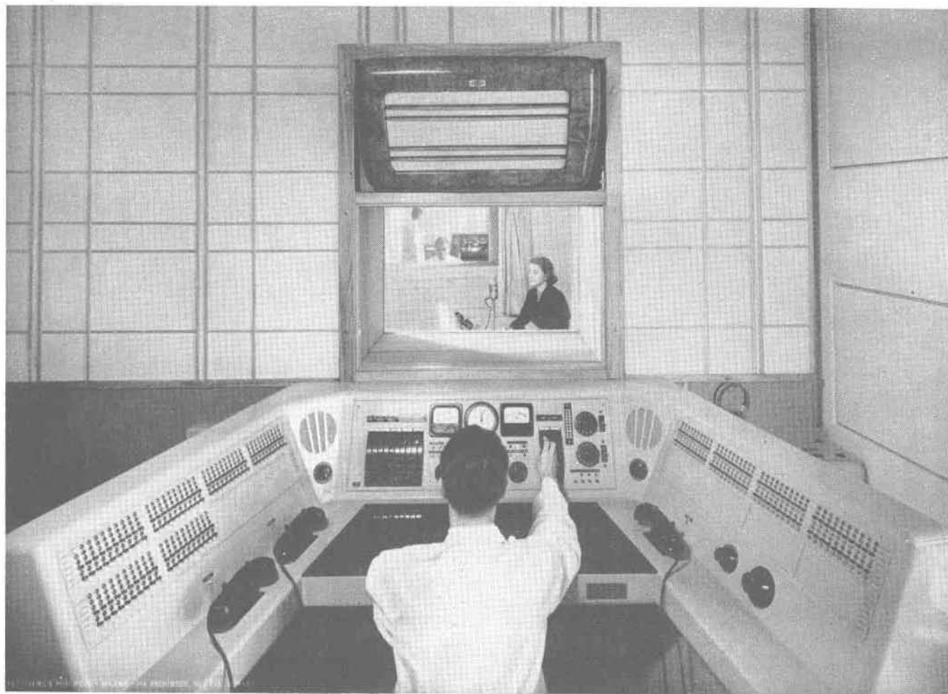
Fig. 1. — Uno degli otto complessi RST: in primo piano la sala del tecnico (T); attraverso la finestra di osservazione lo studio (S); indi la sala di registrazione (R).
