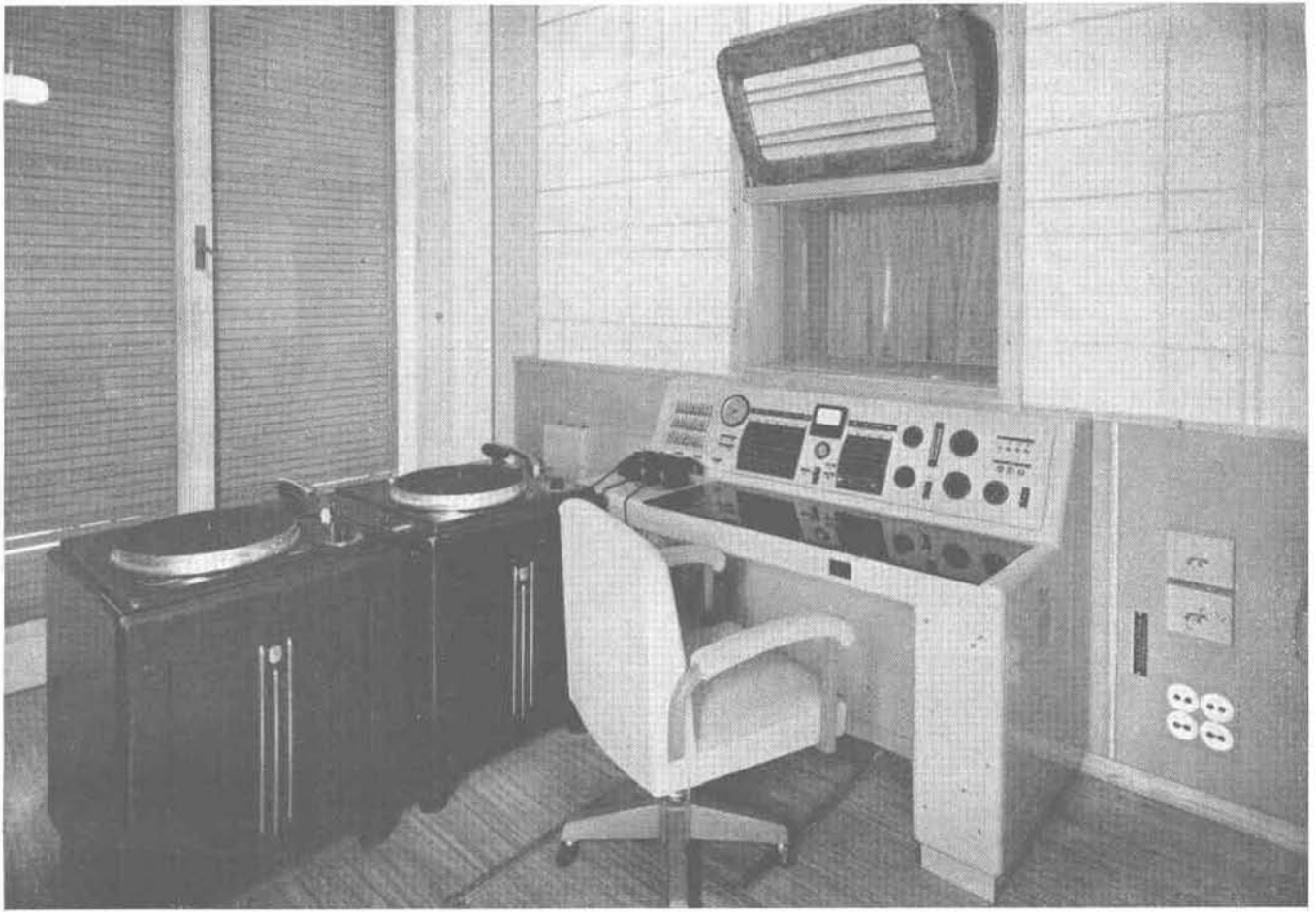
Fig. 4. — Macchine di riproduzione e tavolo di controllo e di dosaggio di una sala R.
