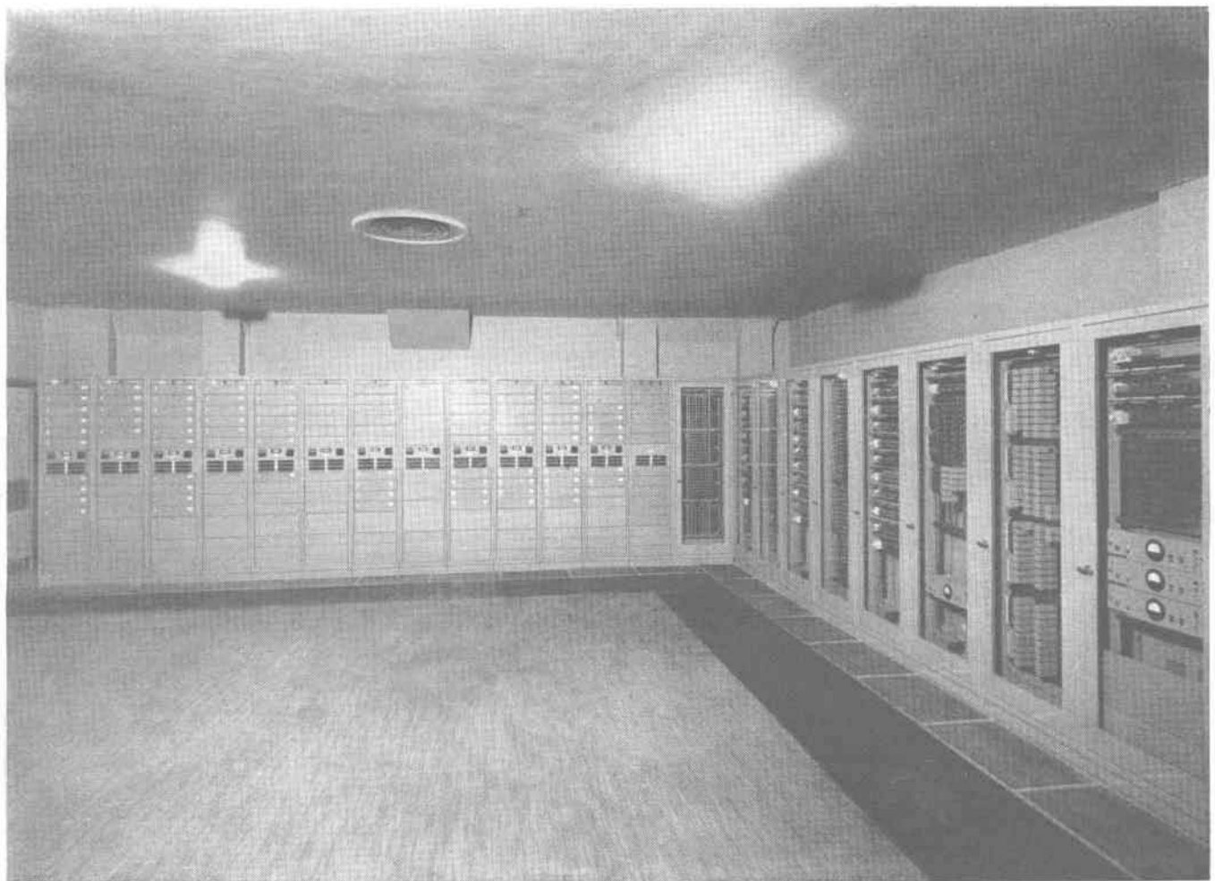
Fig. 11. — Sala degli amplificatori e degli equipaggiamenti dei due complessi prosa, delle stanze di eco e dell'auditorio per dibattiti.
